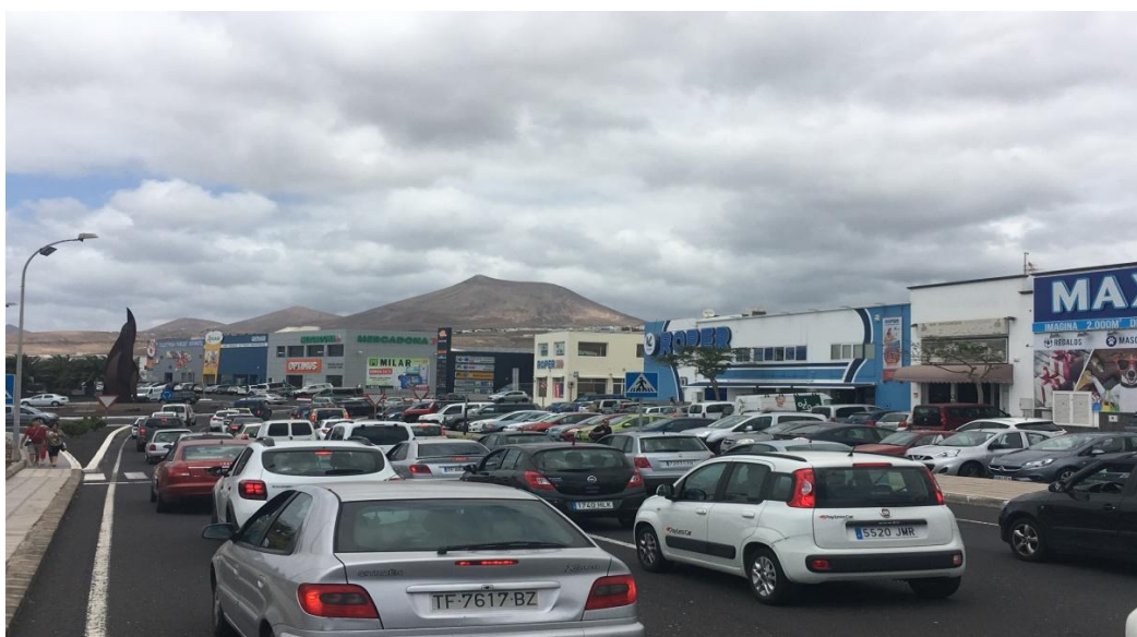
Ilustración 4 - Vista de la LZ-2 junto al paso inferior que conecta las zonas norte y sur de Playa Honda.
