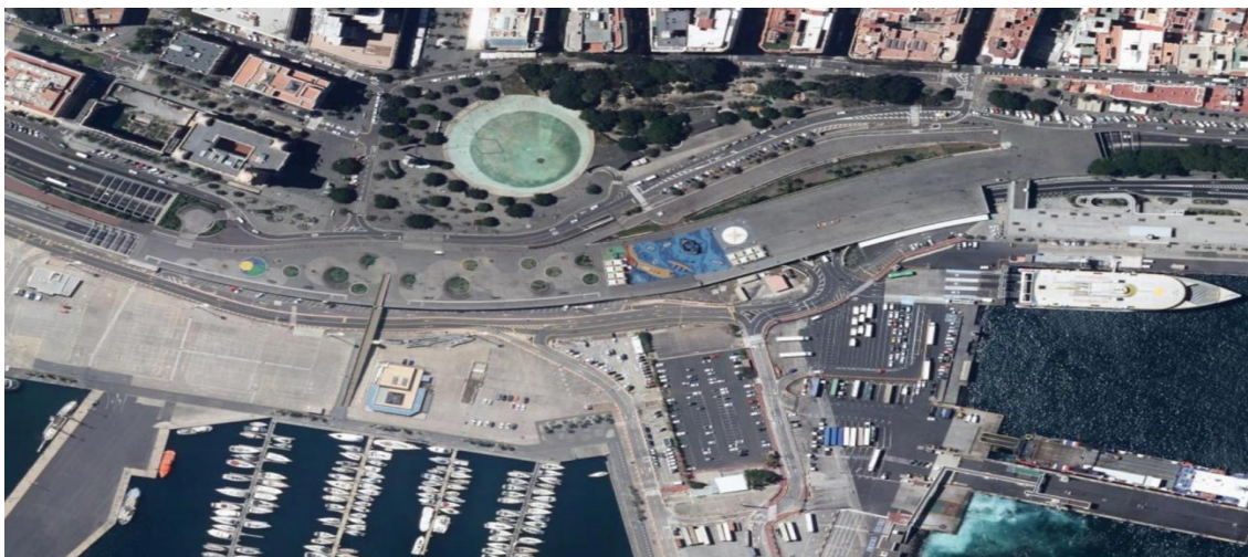
Figura n.6.- Soterramiento en la Plaza de España.
